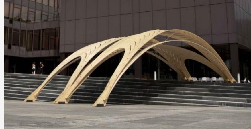
Photo - Construction en bois temporaire
