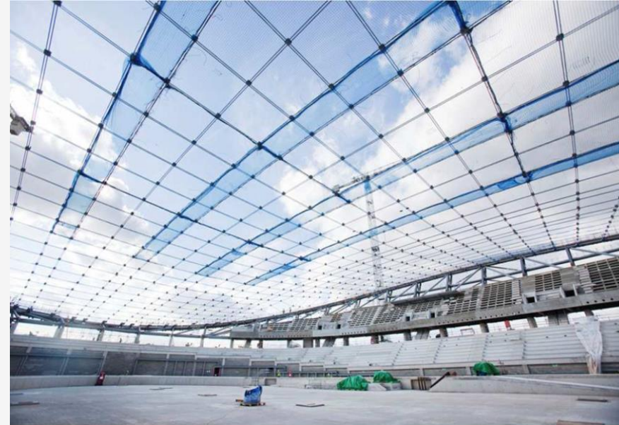
Nappe de câble
