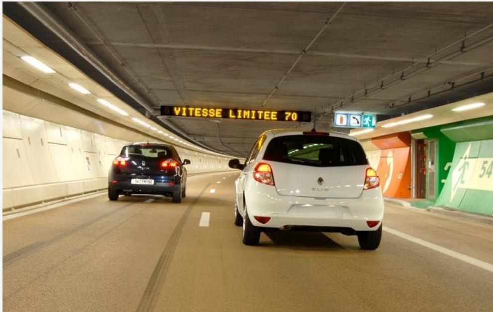
Duplex A86 : prévention de la claustrophobie et des accidents
