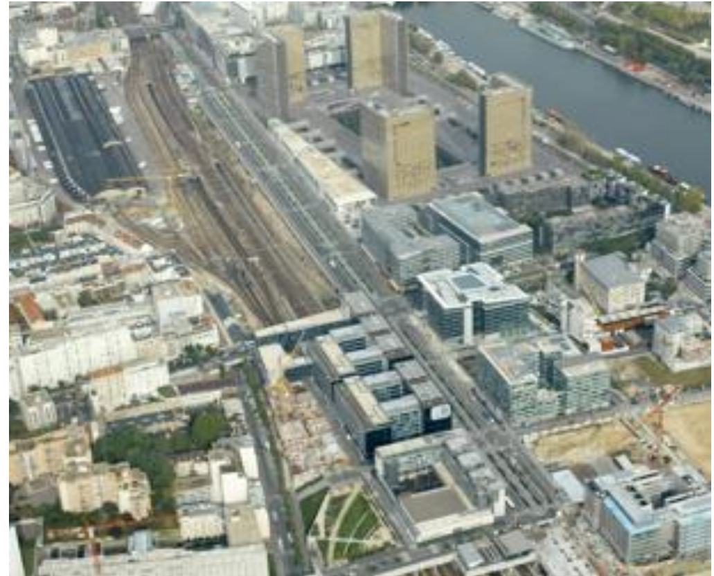
Nouvelles constructions sur la dalle de couverture - Source : SEMAPA
