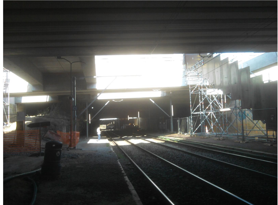
Travaux de couverture de la Gare de Boitsfort encore en fonctionnement – Photo Joel Idt
