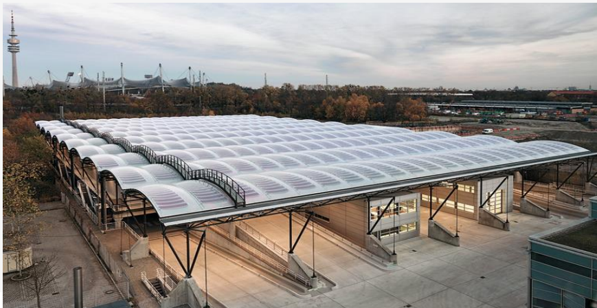
Photo – Toiture pour véhicules de transport
