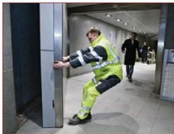
Porte anti-inondation dans le métro de Copenhague (European Environment Agency, 2014)
