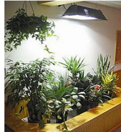
Exemple de LED horticole installé au droit de la composition végétale
